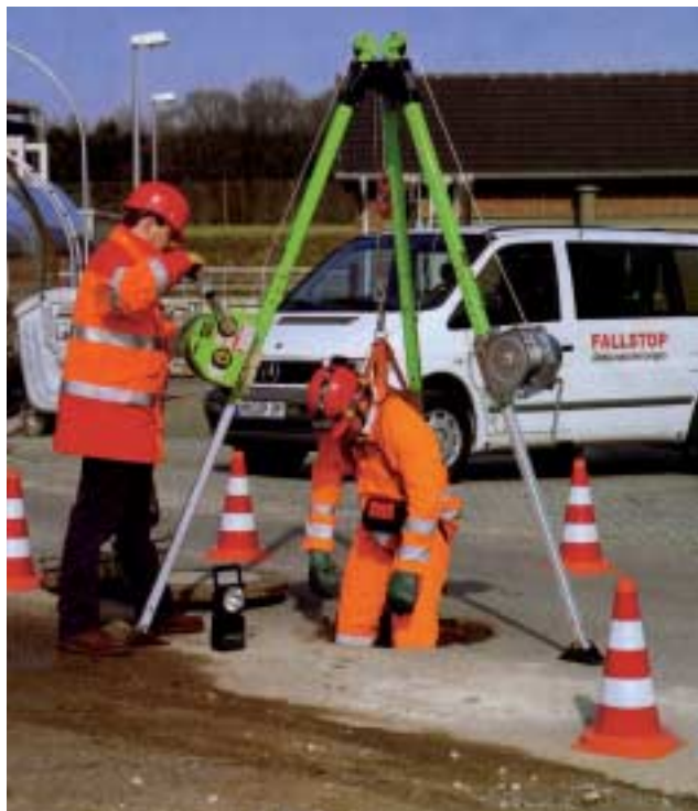
Bild 18: Rettung aus einem Schacht
