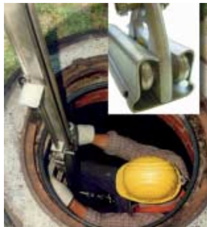
Bild 9: Steigleiter mit Mittelholm, Steigschutzeinrichtung und steckbarer Haltevorrichtung
