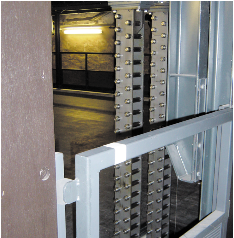
Antrieb einer Versenkeinrichtung mit Schubketten
