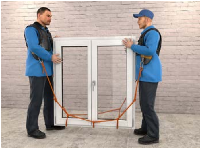
Abb. 7 Einsatz von Tragewesten in Verbindung mit einem Netz für den Transport von Fenstern
