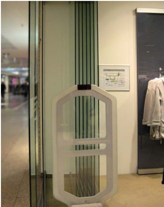
Abb. 6 in der Parkstellung geschützte Glaskanten
