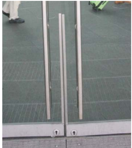
Abb. 5 Kantenschutz für den bodennahen Bereich
