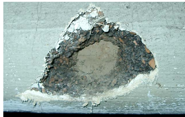
Beschädigte Teerkorkisolierung
