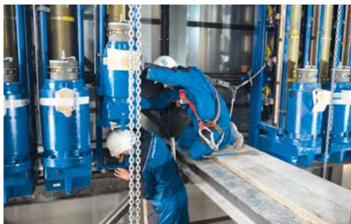
Einbau von Winden in der Staatsoper Berlin. Foto: Waagner-Biro
