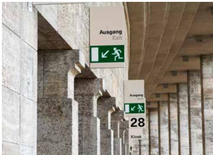
Fluchtwege, Geländerhöhe, Raummaße: Anforderungen der Arbeitsstättenverordnung übersteigen hier oft Forderungen der Landesbauordnung
